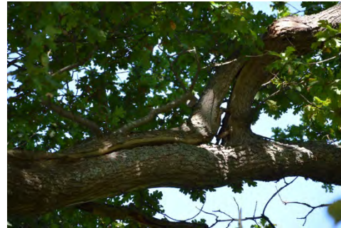
Foto av sprickan
