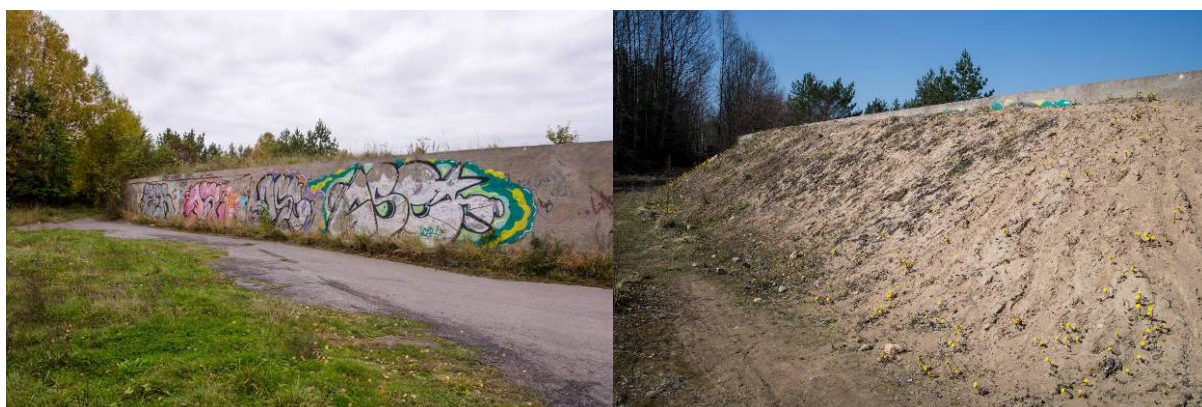
Cementvägg före åtgärd och cementvägg med sandvall.
